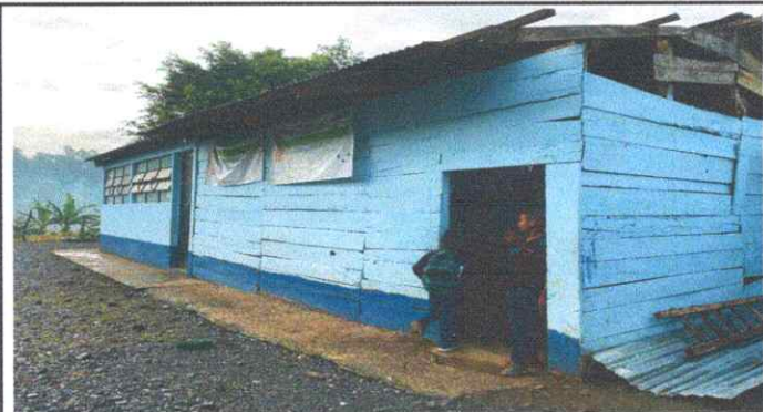
Foto 1: MEJORAMIENTO DE PAREDES DE MADERA A BLOCK
