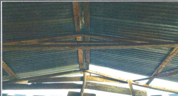
Foto 2: SUSTITUCION ESTRUCTURA DE MADERA POR METAL
